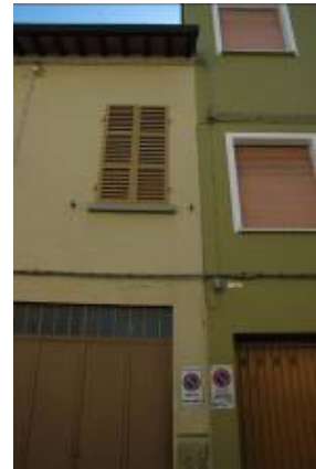
Figura 5.95 osservazione n. 13. Cedimento del terreno di fondazione conseguente alla concentrazione di carico derivante dalle aperture dei garage. La cellula più bassa esibisce le classiche lesioni da cedimento terminale.
