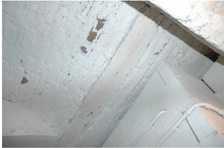
Figura 4.6 "Ripartitore" di legno su volta laterizia nei locali cantinati (p.la 118).
