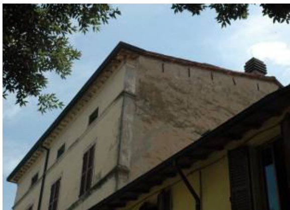
Figura 5.78 Legature con capochiave a gomito agganciati alle membrature di copertura.
