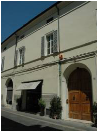
Figura 5.104 Due casi di disallineamento delle aperture
