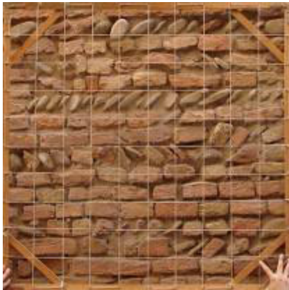
Figura 5.57 Rilievo del campione murario 12
