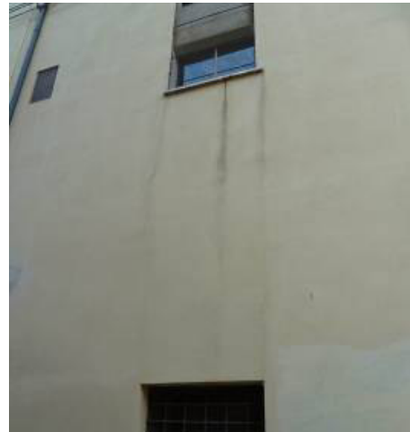
Figura 5.87 osservazione n. 5. Supponendo che dei due maschi murari centrali, quello di sinistra si abbassi più di quello di destra, i sottofinestra di destra sono forzati a ruotare con verso antiorario, quello di sinistra con verso orario, con conseguente apertura di lesioni verticali di distacco tra sottofinestra e maschi murari.
