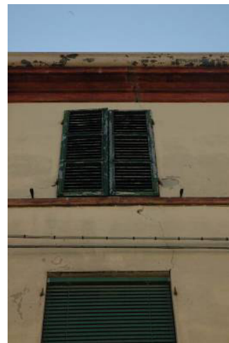
Figura 5.91 osservazione n. 9. . Le lesioni si sviluppano nei sottofinestra, quasi in verticale, ma con un andamento comunque direzionale che può essere anche qui ricondotto alla forma dell'arco. Non si può escludere una influenza dei piani interrati con concentrazione di carico in corrispondenza dell'asse del prospetto.
