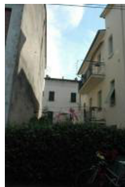
Fig. 17 – Vuoto urbano su via Mura Polveriera
