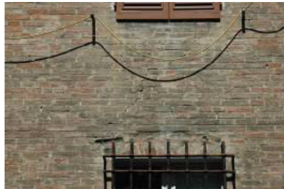
Figura 5.89 osservazione n. 7. cedimento intermedio corto con lesioni diagonali nei sottofinestra, simmetriche rispetto all'asse del prospetto, e lesione verticale in chiave dell'apertura sommitale centrale.
