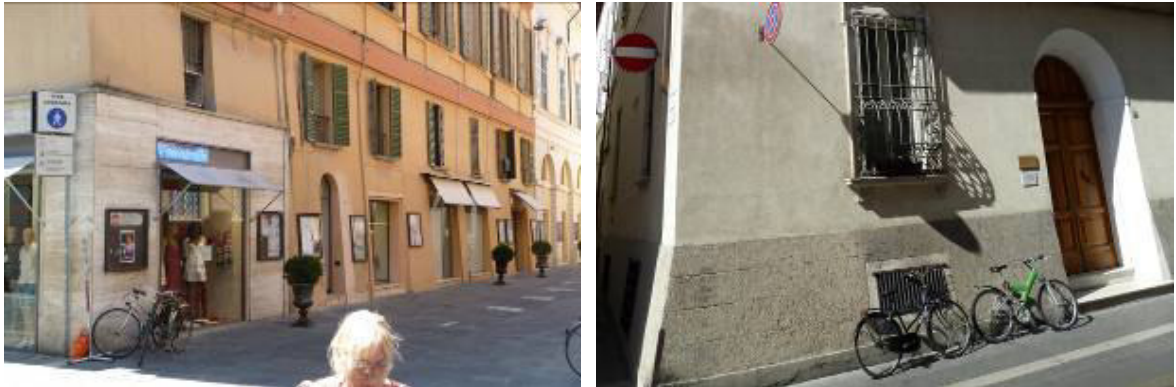
Figura 5.108 Muri a scarpa al piano terra (Aggregato V.01) alla base della parete (Aggregato V.05).
