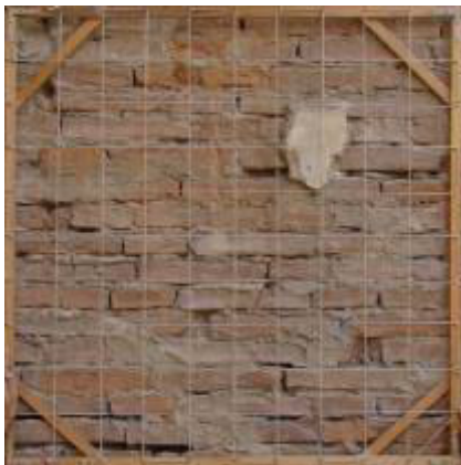
Figura 5.52 Rilievo del campione murario 05
