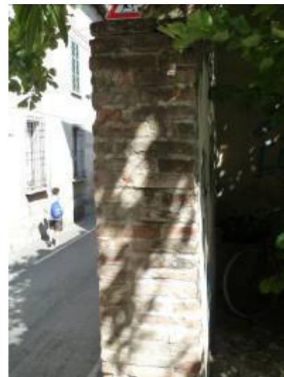
Figura 5.63 Rione verde (V.11): sezione muraria a vista, residuo di un edificio demolito
