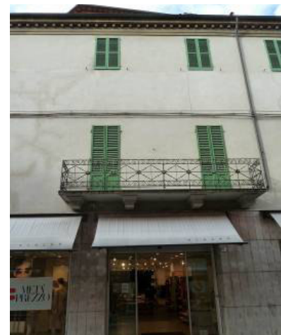
Figura 5.96 osservazione n. 14. La parete al piano terra è quasi scomparsa per le aperture dei negozi. I livelli superiori si abbassano e si creano lesioni diagonali ad arco alle estremità della zona interessata (visibili solo a sinistra; a destra sono probabilmente nascoste dal paramento in mattoni) e una lesione verticale nel parapetto tra le due finestre centrali – che corrisponde alla “chiave” dell’arco.
