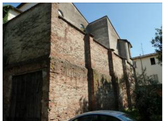
Figura 5.81 Contrafforti in muratura di laterizi (V.14).
