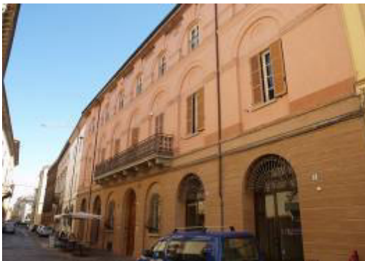
Fig. 24 – Il fronte dei palazzi via Severoli
