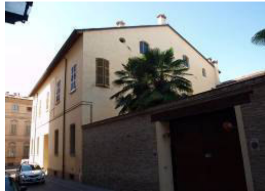
Fig. 27 – Edificio su via Scaletta
