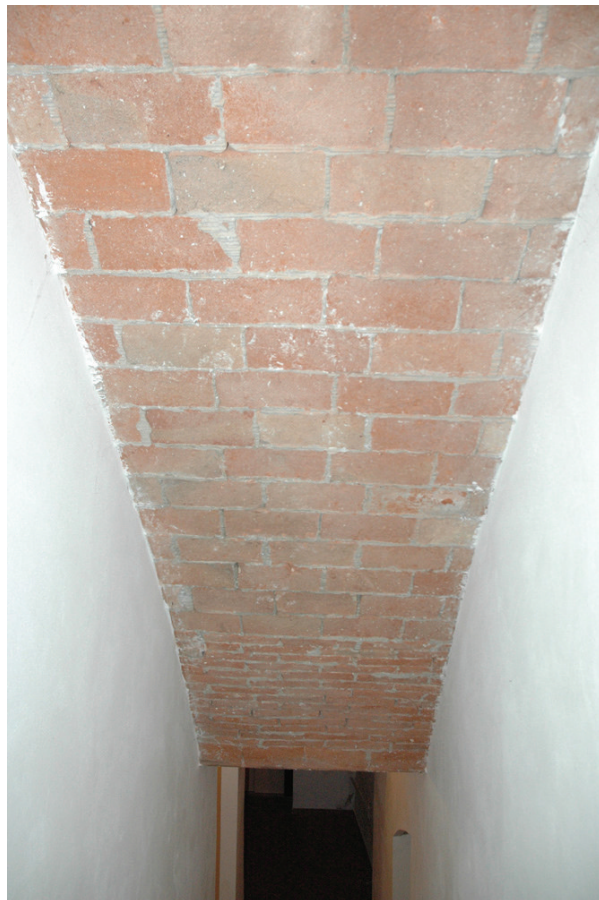
Figura 4.1 Intradosso di una volta in foglio che sottende una scala: i primi filari di mattoni sono posati con giacitura orizzontale, solo dopo in verticale in foglio (p.lla 119).
