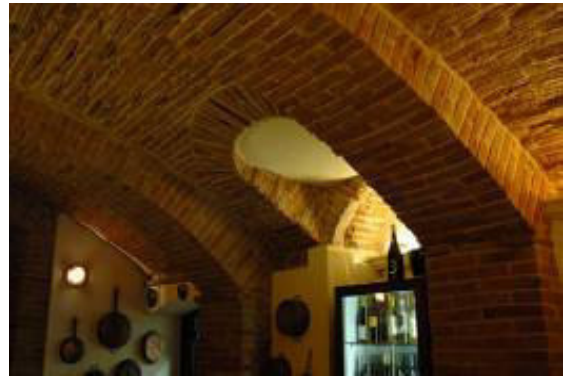
Figura 5.65 Rione rosso (R.01): strutture murarie al livello interrato
