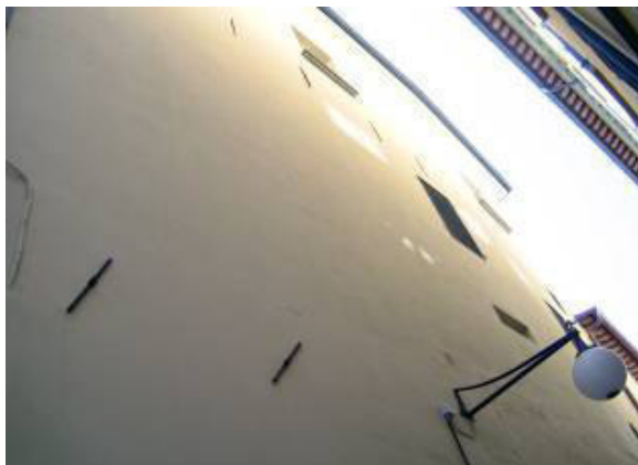
Figura 5.76 Incatenamenti diffusi a più livelli.
