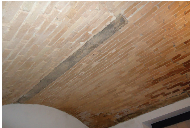
Figura 4.7 "Ripartitore" di legno su volta laterizia nei locali cantinati (p.la 119).
