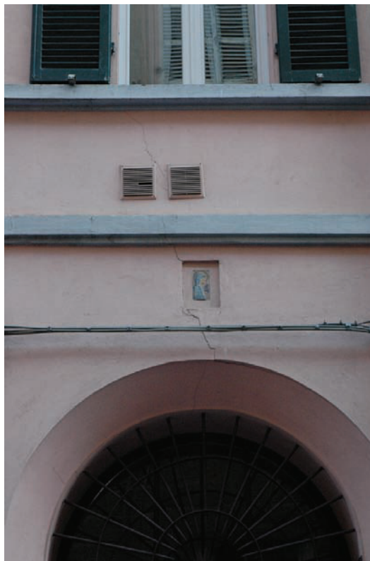
Figura 3.8 Lesione tra la chiave dell'arco del portone d'ingresso e la finestra soprastante (p.lla 125).
