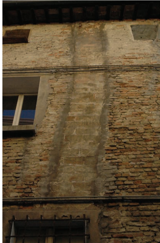
Figura 4.11 Chiusura con laterizi posti in verticale di una canna fumaria (p.lla 110).
