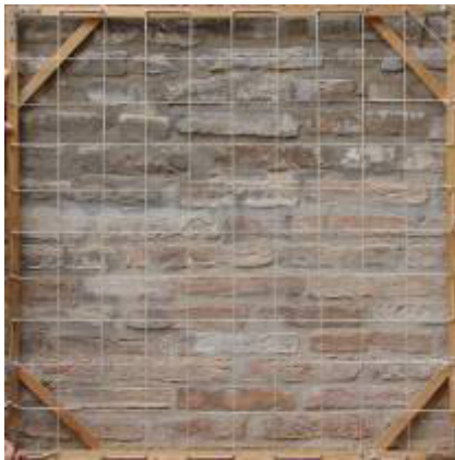
Figura 5.56 Rilievo del campione murario 11: in alto la muratura antica e in basso la stilatura di restauro.
