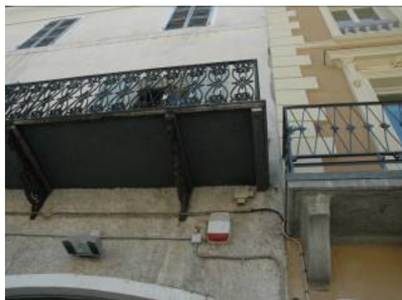
Figura 5.41 Rione nero (N.02), due balconi con strutture portanti differenti. Possibili trasformazioni o ricostruzioni.
