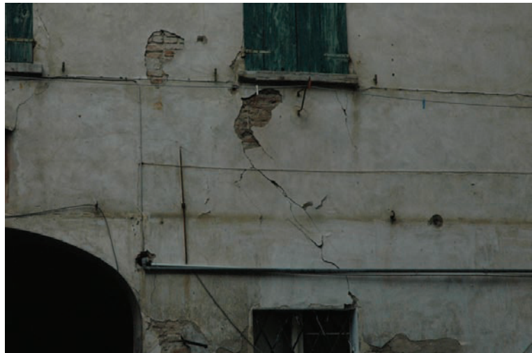
Figura 3.5 Gravi lesioni inclinate tra bucatore su corte interna (p.lla 110).
