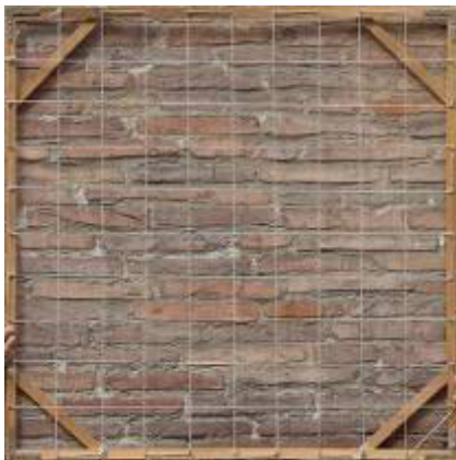
Figura 5.53 Rilievo del campione murario 08
