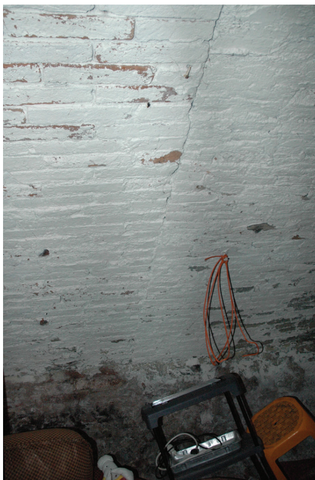
Figura 4.10 Ripresa costruttiva su volta di laterizi (p.lla 125).
