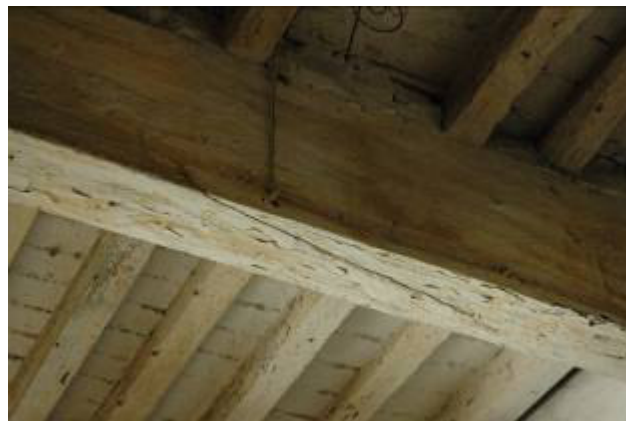
Figura 5.68 Dettaglio di solaio ligneo in ambiente interno (N.03)
