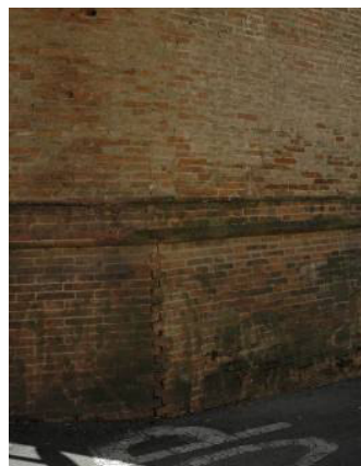
Figura 5.86 osservazione n. 4. Caso di incerta attribuzione. Le lesioni con maggiore apertura in basso potrebbero essere dovute a una traslazione orizzontale del terreno ma, in mancanza di informazioni più precise, si potrebbe anche pensare a un cedimento terminale della parete, come testimoniano le lesioni sommitali, seguito da un movimento secondario di assestamento responsabile delle lesioni alla base.
