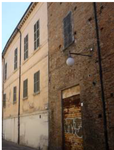
Figura 5.103 .Due casi di solai sfalsati tra edifici contigui (Aggregati G.04 e V.05).
