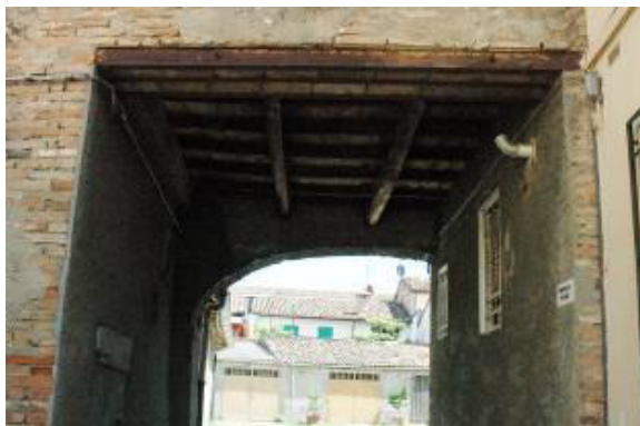
Figura 5.66 Sottopasso con solaio ligneo (Rione bianco)
