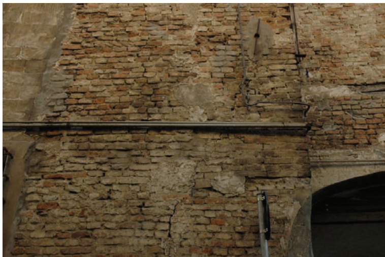
Figura 3.1 Paramento murario con lesioni diffuse su via Zuffe (p.lla 110).
