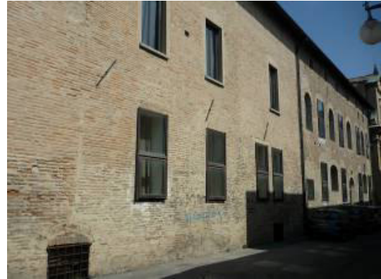
Figura 5.106 Il capochiave a bolzone di una catena isolata (Aggregato V.04) e un incatenamento multilpo su un solaio (Aggregato V.07).
