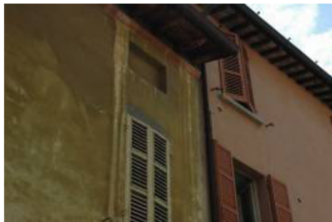
Figura 5.93 osservazione n. 11. La lesione tra i due fabbricati, presumibilmente dovuta all'abbassamento relativo del più pesante fabbricato di destra, segue il profilo delle morsa laterizie sviluppandosi comunque secondo il classico andamento diagonale.
