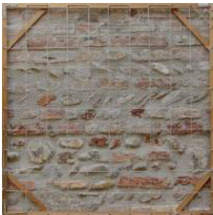
Figura 5.58 Rilievo del campione murario 15
