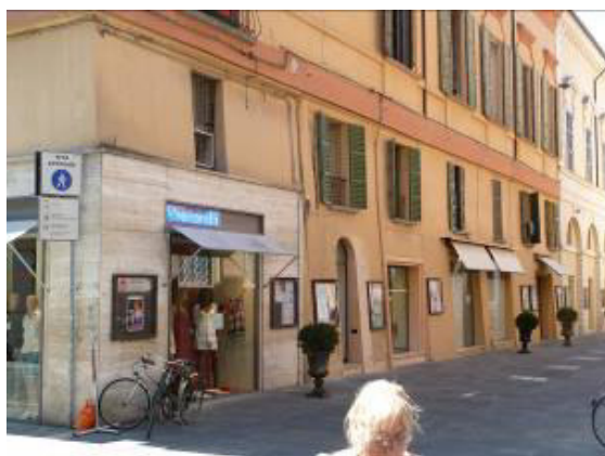
Figura 5.80 Muro a scarpa sul corso Mazzini (V.01).
