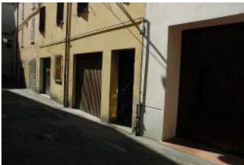
Fig. 14 – Allargamenti murari in via Acquatino
