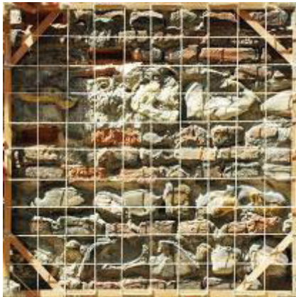
Figura 5.60 Rilievo del campione murario 26
