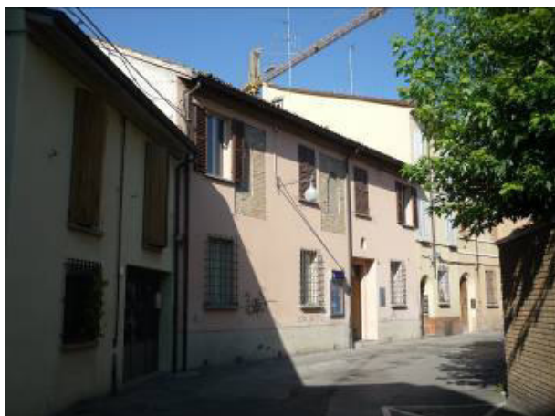
Figura 5.38 Rione giallo (G.08), il rifacimento del prospetto ha messo in evidenza le aperture della fase medievale. Le finestre attuali risultano in posizione differente da quelle preesistenti.
