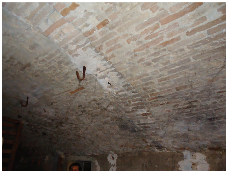
Figura 4.9 Ripresa costruttiva su volta di laterizi (p.lla 537).
