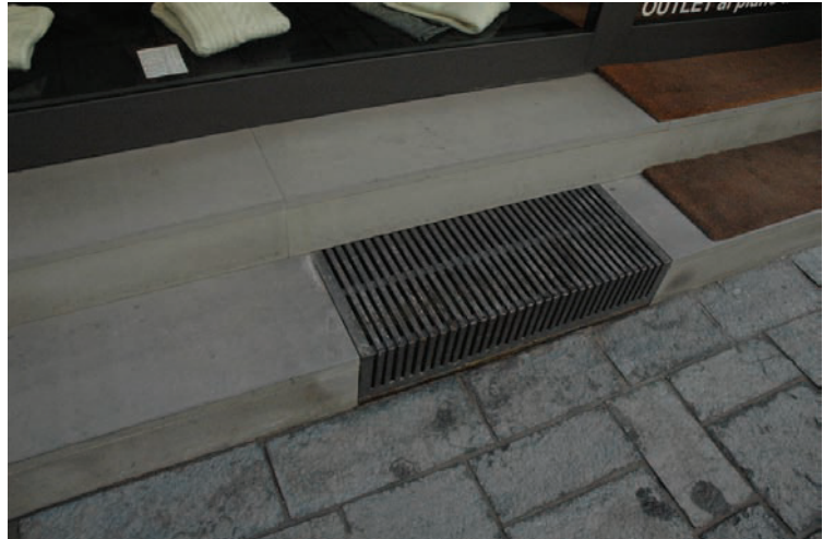
Figura 4.4 Griglia di aerazione su via Torricelli per i locali cantinati (p.lla 118).
