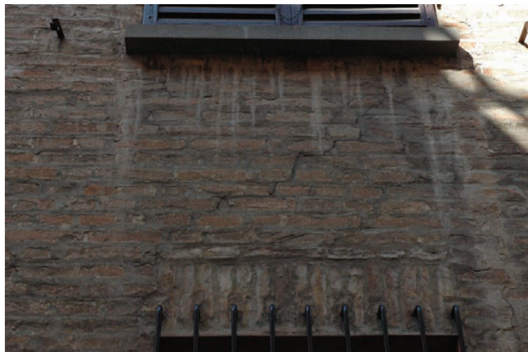
Figura 3.2 Lesioni diffuse su pannello sottofinestra (p.lla 110).
