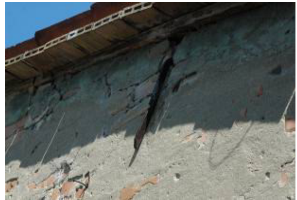
Figura 5.107 Incatenamento multiplo delle orditure di copertura (Aggregato B.03) e dettaglio della piastra metallica piegata che “arpiona” la membratura lignea al muro (Aggregato B.08).
