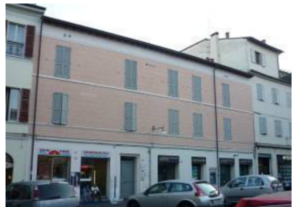
Fig. 11 – Ampliamenti murari al piano terra e sopraelevazioni su piazza del mercato.
