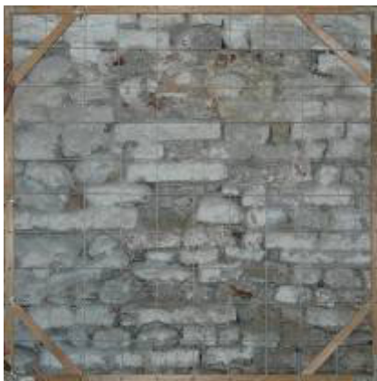
Figura 5.61 Rilievo del campione murario 30°
