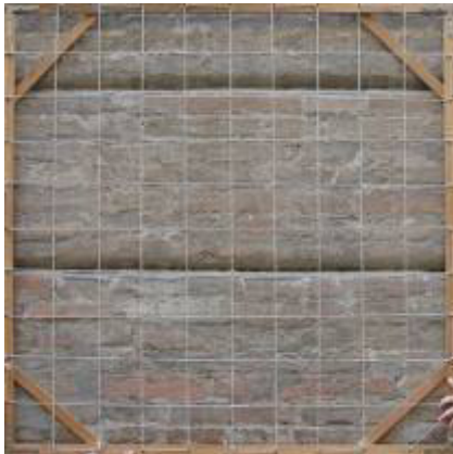
Figura 5.51 Rilievo del campione murario 14
