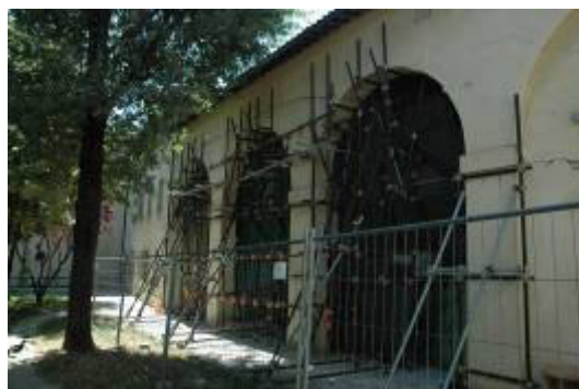
Figura 5.85 osservazione n. 3. In questo caso la presenza accertata del canale in prossimità della zona interessata dal forte cedimento evidenzia drammaticamente il ruolo delle condizioni del sottosuolo. La lesione ad arco interessa le due pareti ortogonali del cortile e appare addirittura in continuità in corrispondenza dello spigolo comune. Il cedimento è terminale per la parete nella quale si apre l'accesso al cortile e intermedio sulla parete con gli archi.
