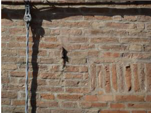
Figura 5.106 Il capochiave a bolzone di una catena isolata (Aggregato V.04) e un incatenamento multilpo su un solaio (Aggregato V.07).
