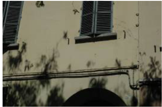
Figura 5.90 osservazione n. 8. cedimento intermedio corto con massimo disassato rispetto alla mezzeria dell'edificio e lesioni ad arco che interessano anche il fabbricato contiguo. Il minor numero di aperture fa sì che le lesioni interessino anche i pieni murari (ovvero, rispetto al caso precedente, esistono minori percorsi di debolezza).
