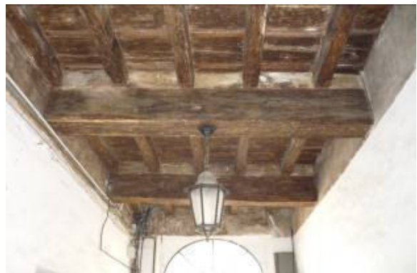
Figura 5.67 Sottopasso con solaio ligneo nel Rione giallo (G.12)
