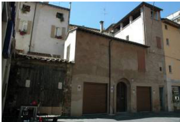
Figura 5.102 Aperture allargate al piano terra
