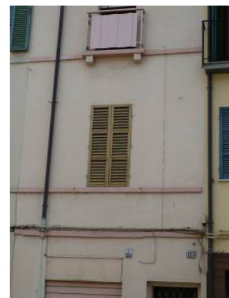
Figura 5.97 osservazione n. 15. Cedimento fondale dovuto all’allargamento dell’apertura al piano terra
