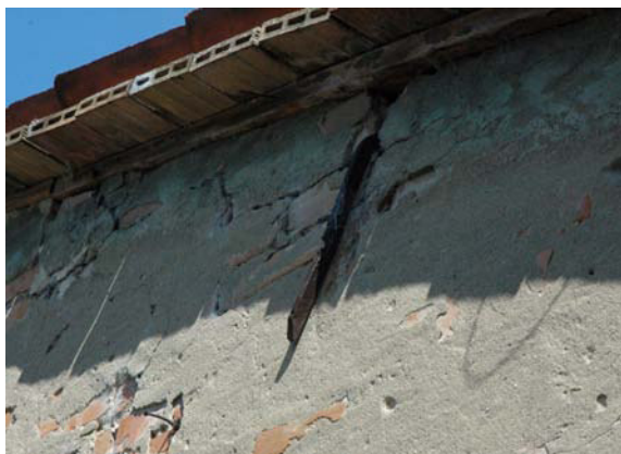
Figura 5.79 Dettaglio di un capochiave a gomito.
