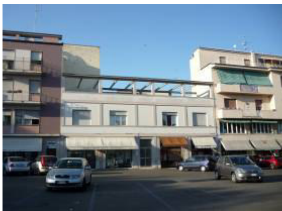
Figura 5.10: Edifici speciali, non inclusi nell'indagine: fabbricati con struttura intelaiata in calcestruzzo armato negli aggregati G.22 e N.06 .
