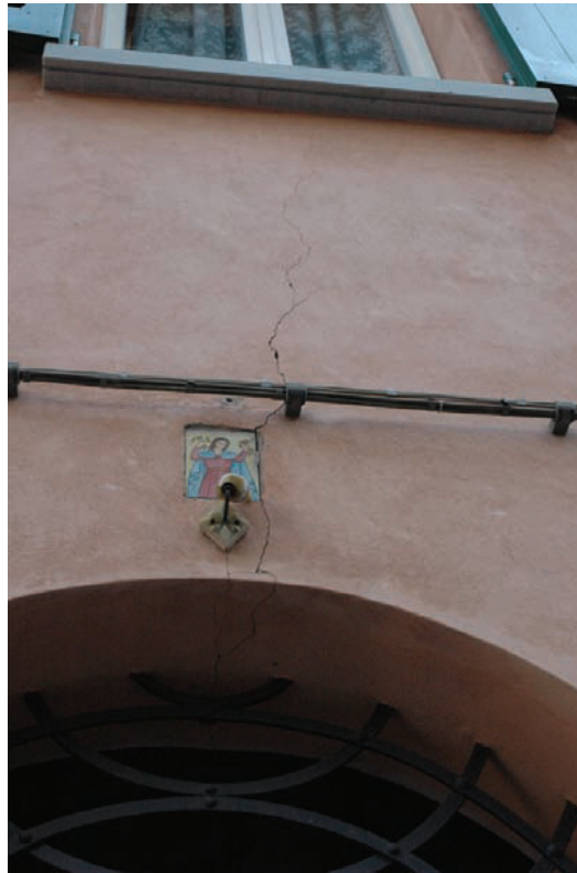
Figura 3.7 Lesione tra la chiave dell'arco del portone d'ingresso e la finestra soprastante (p.lla 114).
