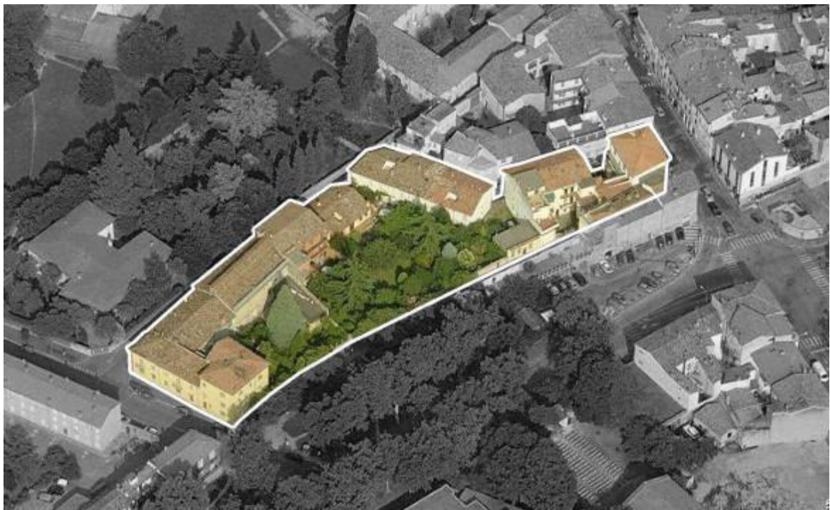
Figura 5.8: Foto a volo d'uccello dell'aggregato V.35 (da Bing). Recinti murari collegano i tre corpi .
