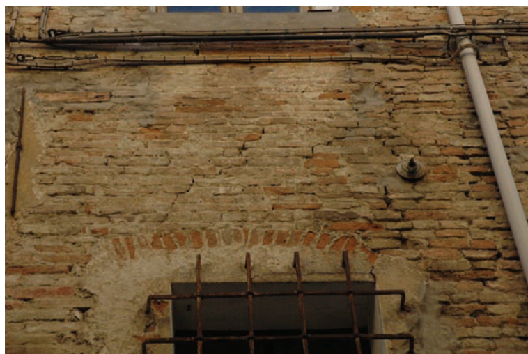
Figura 3.2 Lesioni diffuse su pannello sottofinestra (p.lla 110).
