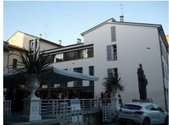
Fig. 9 – Porzione di edificio in c.a.
