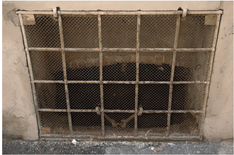
Figura 4.3 Bocca di lupo su via Zuffe: si intravede il bordo della lunetta della volta interna (p.lla 111).
