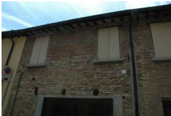
Figura 5.105 Architrave di spessore ridotto di un edificio a due livelli con interpiano di altezza ordinaria (Aggregato B.03) e in corrispondenza del piano sottotetto (Aggregato N.06).
