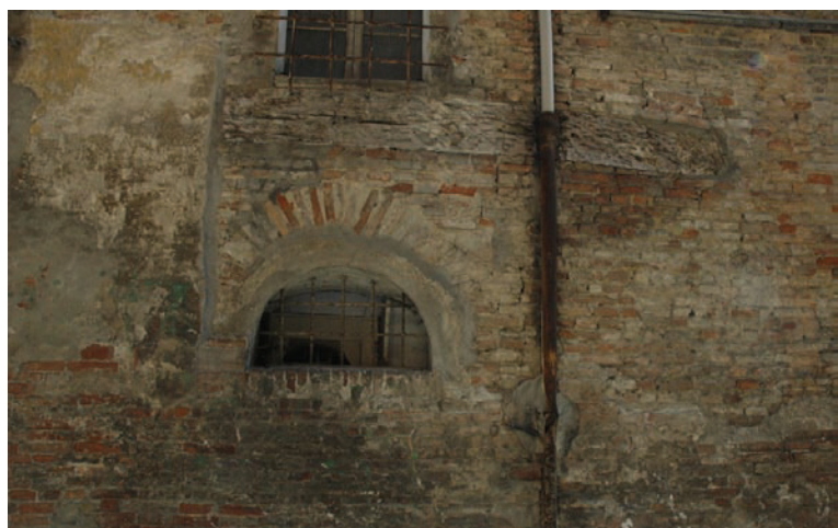
Figura 4.8 Inserto di legno su tessitura muraria di laterizi, su via Zuffe (p.la 110).
